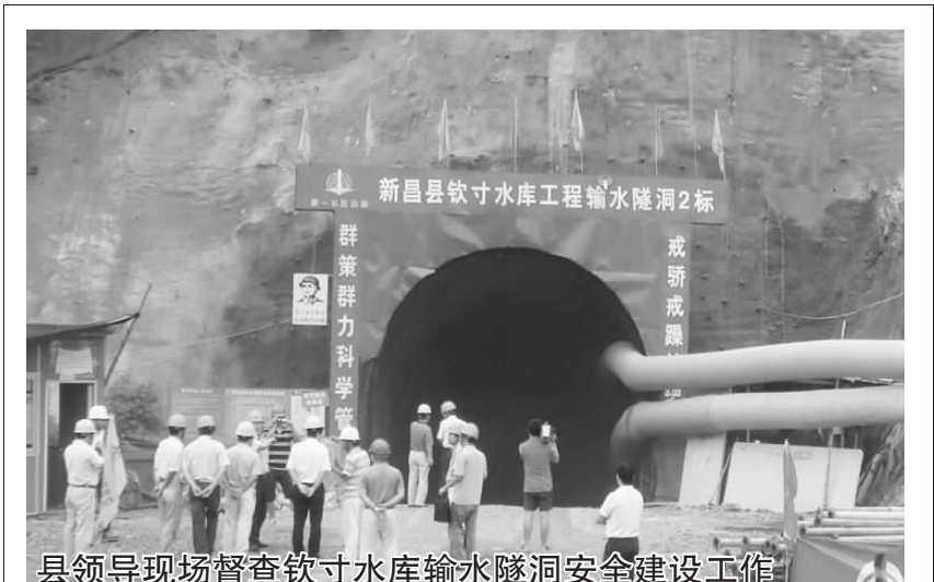
县领导现场督查钦寸水库输水隧洞安全建设工作 新昌新闻网记者王娟敏摄影报道 日前,县领导率领有关部门负责人专程到钦寸水库输水隧洞张车支洞现场督查安全生产工作,并要求高度重视安全工作,确保钦寸水库建设工程顺利推进。
