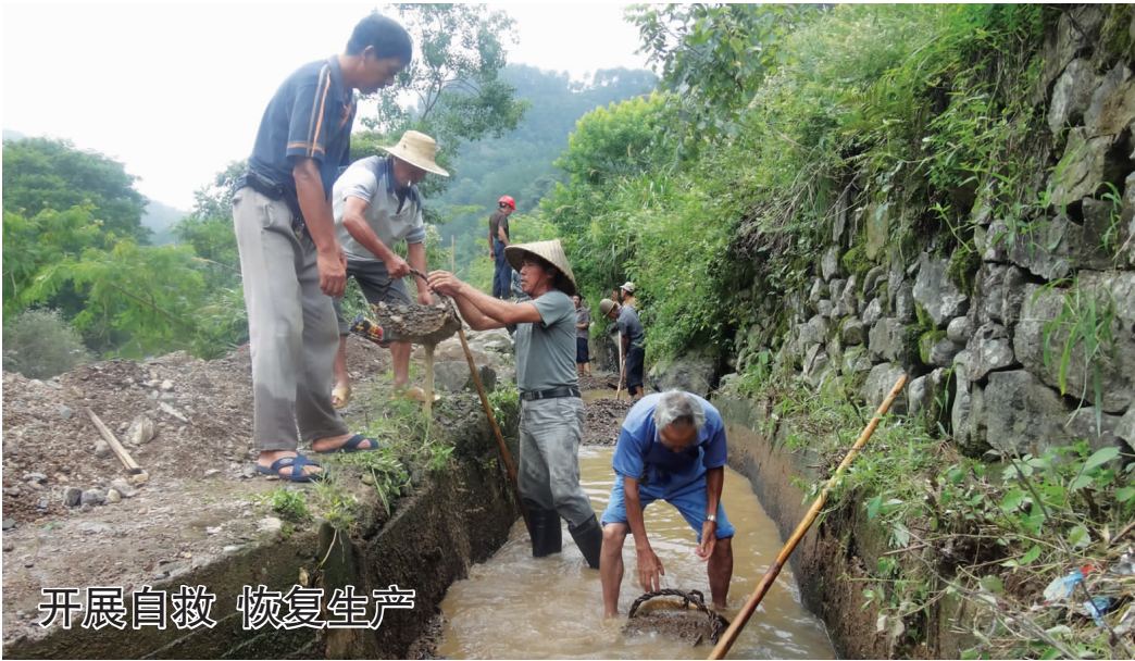
开展自救 恢复生产 强台风“海葵”来袭后,我县各地及时展开电力抢修、道路维修、大棚修复、农作物灾后处理等生产自救工作,尽最大努力将损失降至最低,及早恢复群众的生产生活。图为儒岙镇王渡里村村民正在开沟清渠,尽早恢复投入使用。 (通讯员 俞海丽摄)
