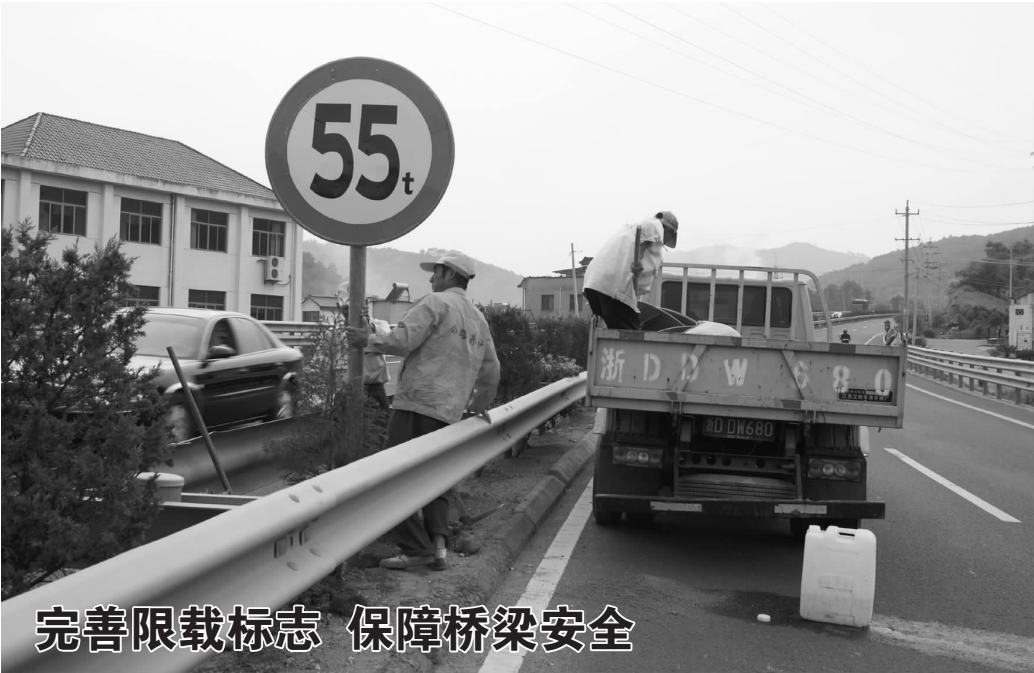
县公路段加强桥梁管理，对 137 座桥梁进行了一次全面的安全隐患排查，对缺失限载标志的 8 座桥梁及时增设标志，对破损、不清晰的标志进行更换，保障公路桥梁运行安全。图为养护工人正在为 104 国道挂帘山通道桥安装桥梁限载标志。（通讯员 俞晨莺摄）
