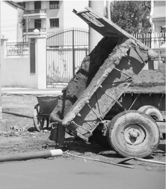
棠村村道路硬化现场
