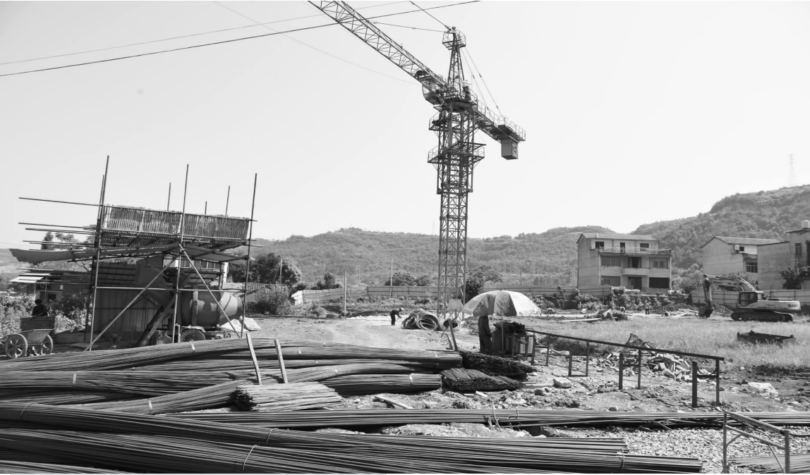
坑下村农民集中居住区建设现场
