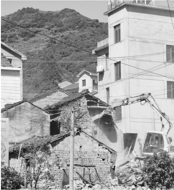
潜溪村拆旧现场
