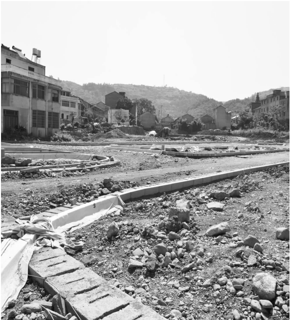
建设中的坑下村休闲公园
