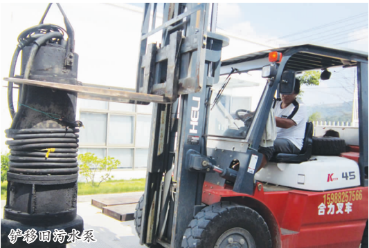
铲移旧污水泵
