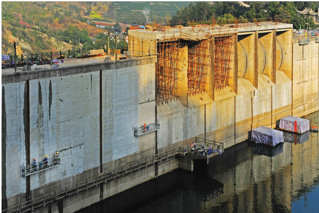
长诏水库大坝维修
