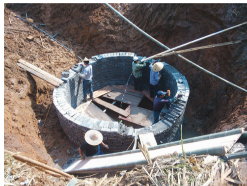
回山镇植林村引水工程
