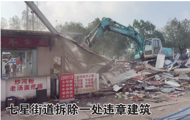
七星街道拆除一处违章建筑 新昌新闻网记者梁凌凌 通讯员何珊摄影报道 昨日,七星街道组织执法人员,依法对石柱湾村村口一带的临时建筑、违章搭建等实施了统一拆除。据统计,本次拆除行动共拆除面积为 800 余平方,有效整治改善了上三高速道口的街面形象。
