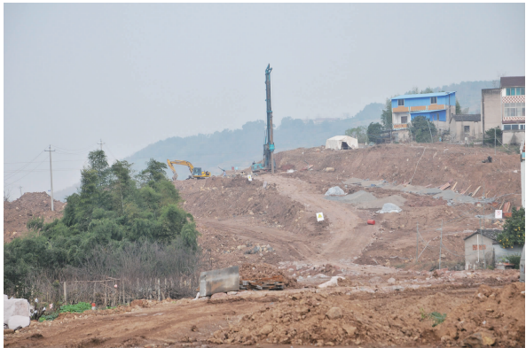
王了山抗滑桩建设进场施工
