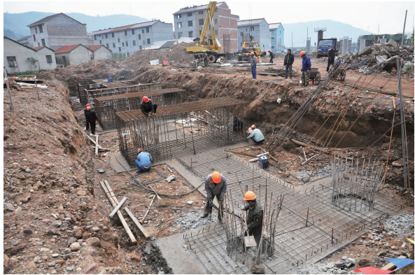
零号桥墩施工现场
