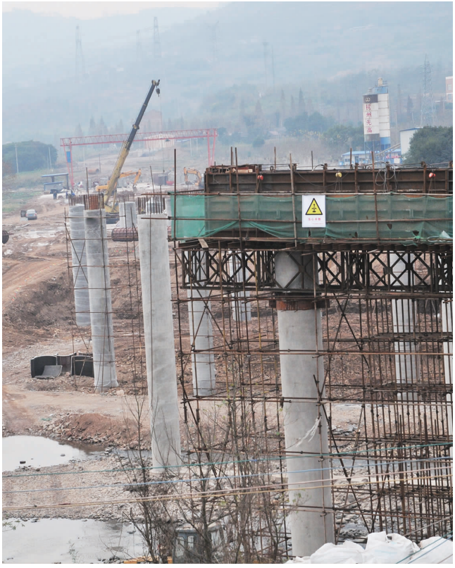
新澄潭大桥开始盖梁浇筑
