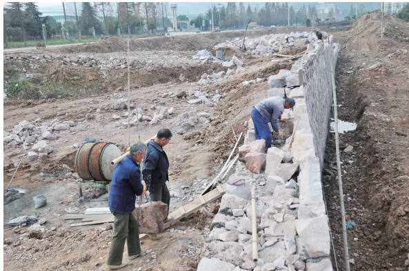
路基挡墙驳砌
