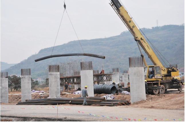
新澄潭大桥早桥桥墩施工
