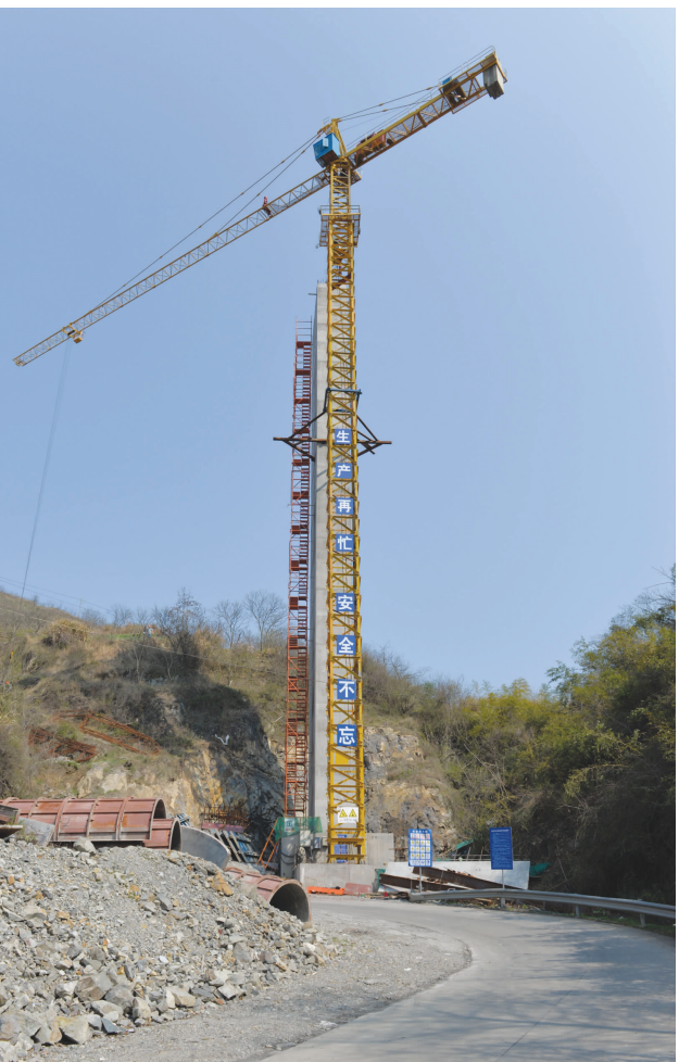
扁石大桥主桥墩浇筑完成
