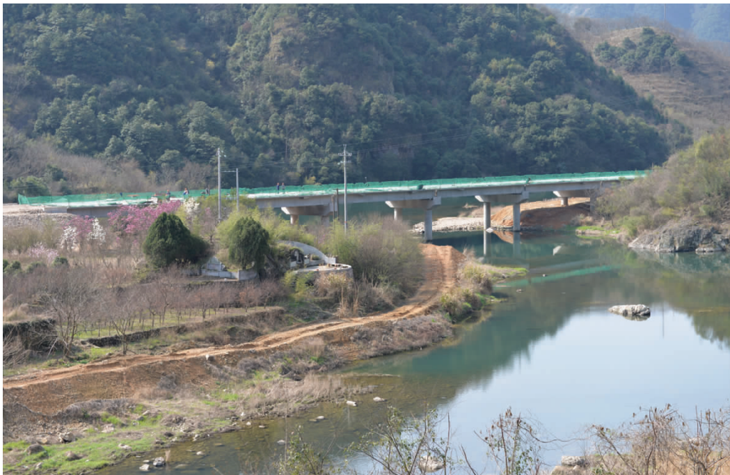
平头山 2# 桥进入桥面施工阶段
