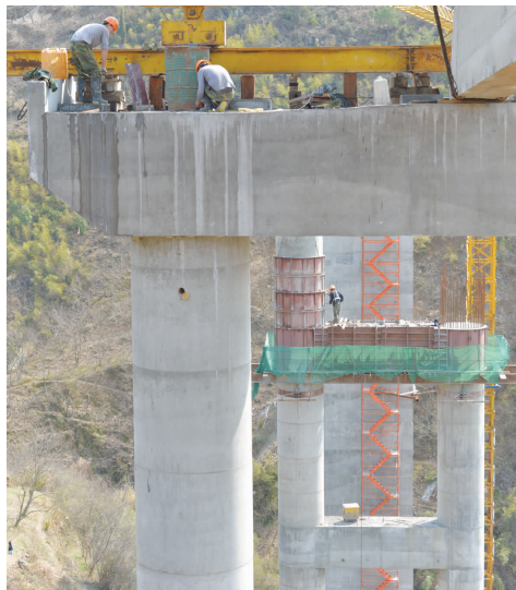
施工人员在做扁石大桥桥板铺架准备
