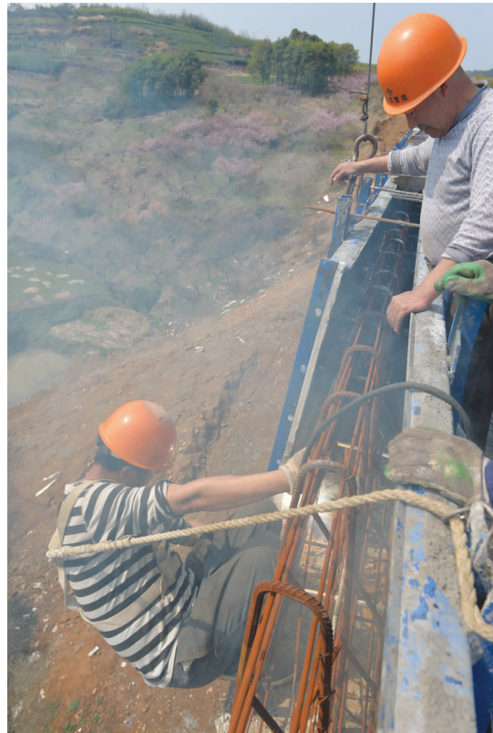
倒平山大桥已进入护栏浇筑阶段
