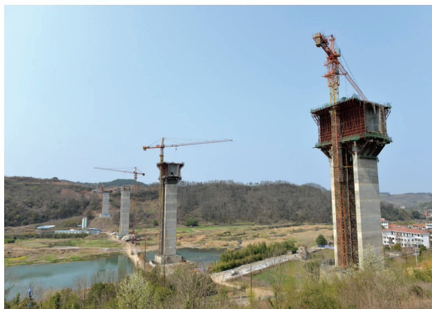
新林特大桥已完成 2 个桥墩的上部结构施工
