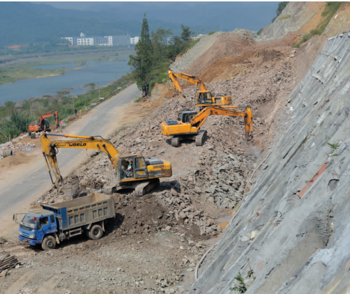
边坡工程土方挖掘
