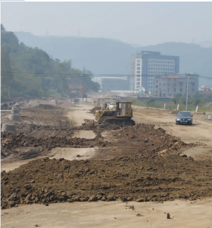
社头桥段路基填压
