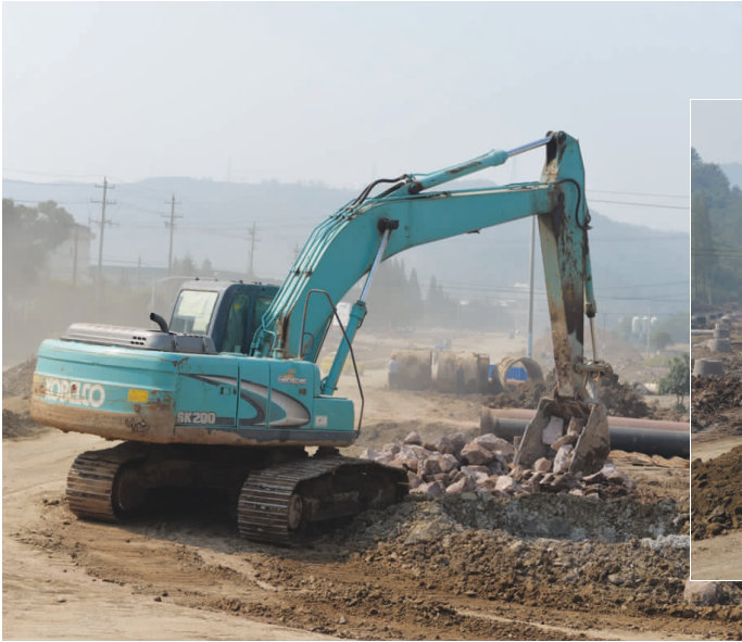
马家庄段管线施工
