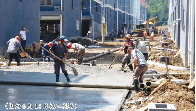
（图为 6 月 14 日施工现场）
