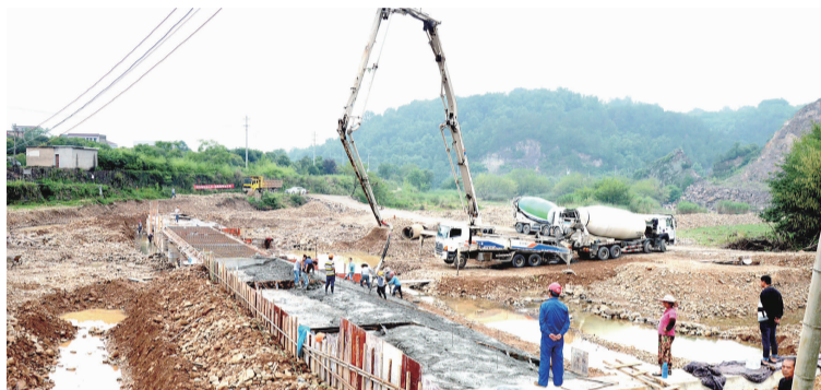
广溪堰施工现场
