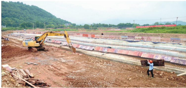
茹洪堰施工现场
