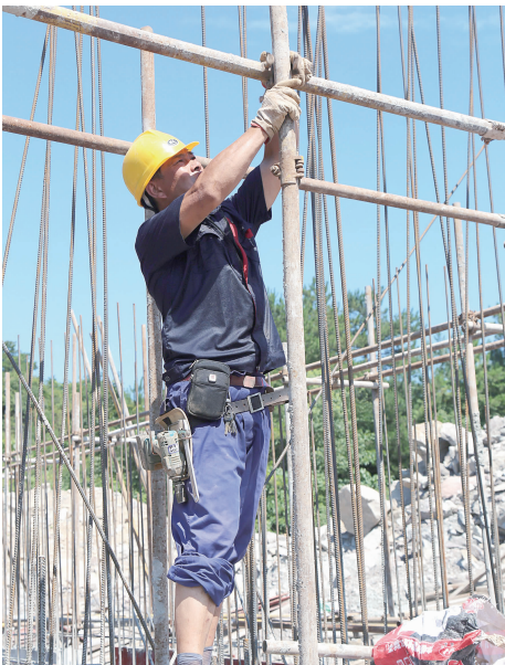
钟山水厂施工者整理脚手架
