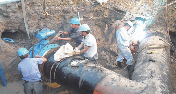
抢修供水主管道
