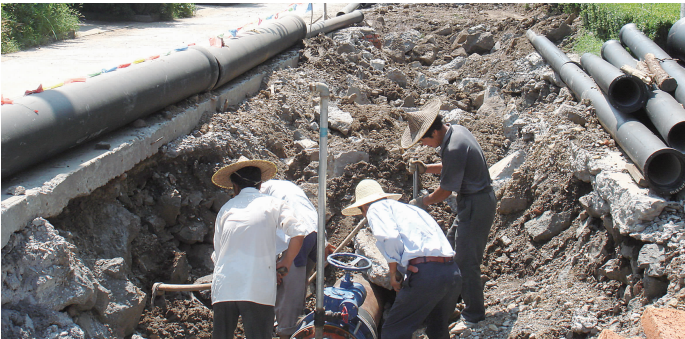
加快城市供水旧管网改造
