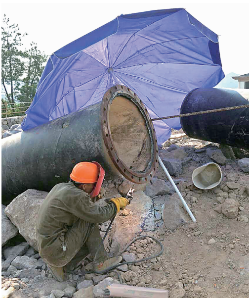
焊接供水管道
