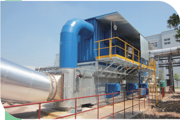
企业新建 RTO 废气焚烧设施
