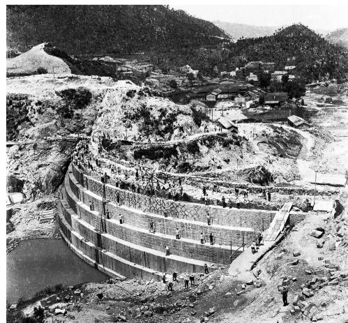
建设中的寨岭水库
