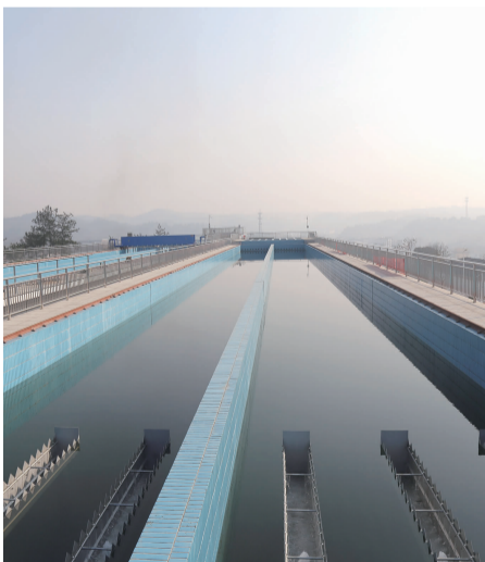
钟山水厂投入运行
