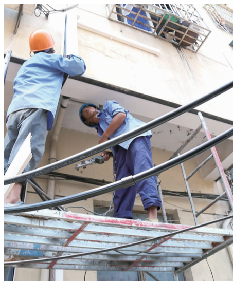
户表改造施工
