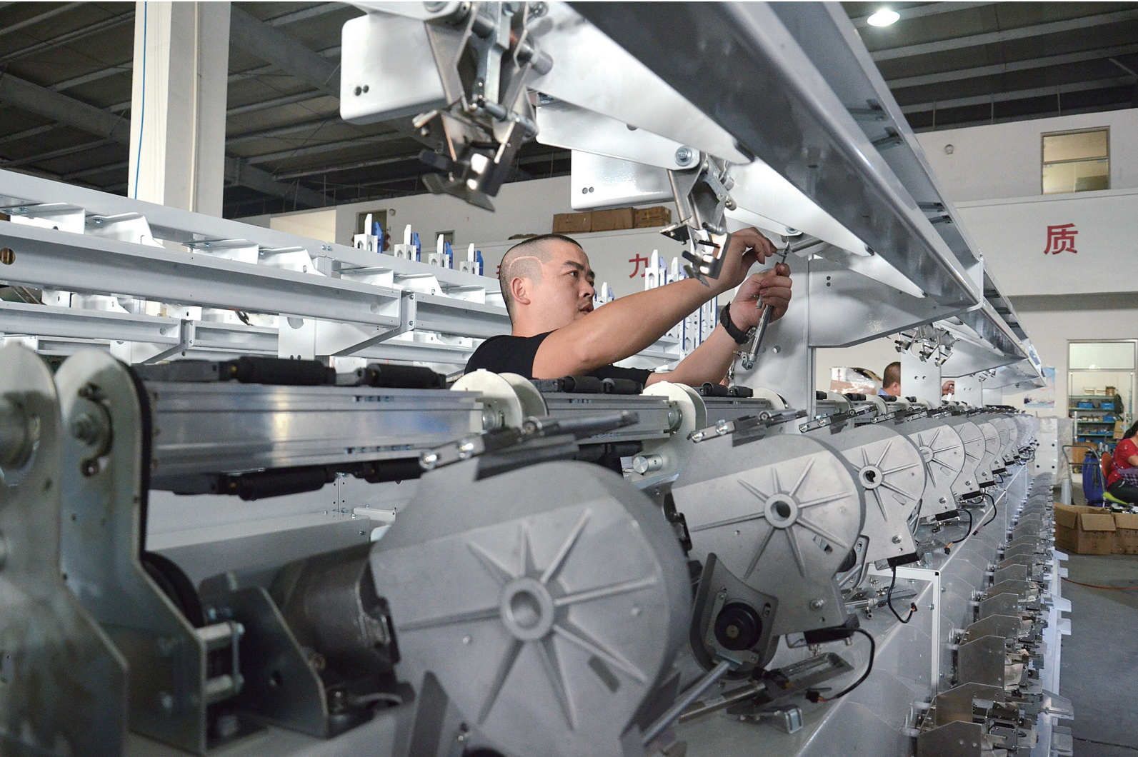
KC522全自动绕线络筒机在公司生产车间安装
