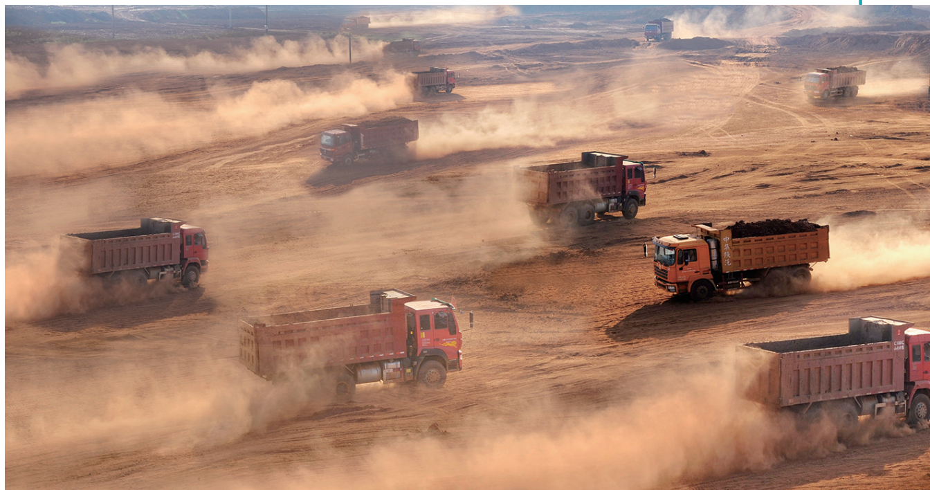
三等奖 建设中的城东开发区(组照) 徐乐安 摄
