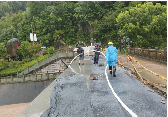
抢修王泗洲村被洪水冲毁的供水管道
