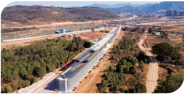
金甬铁路新昌段黄泽江特大桥
