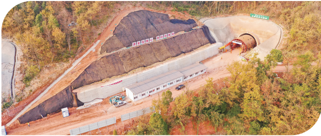
527 国道新昌段一期工程喻家山隧道
