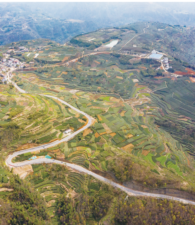
萌马线2期工程 黄潭坑至后岱山段完成沥青摊铺
