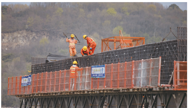
527国道新昌段一期工程黄泽江大桥
