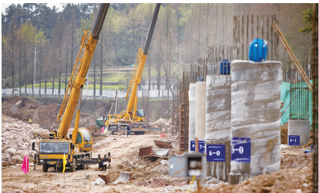
新镜线龟岩潭段提升改造工程
