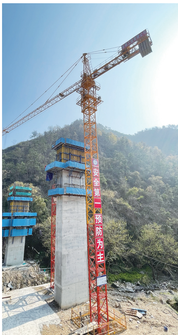
太下线改建工程坑下山4号桥
