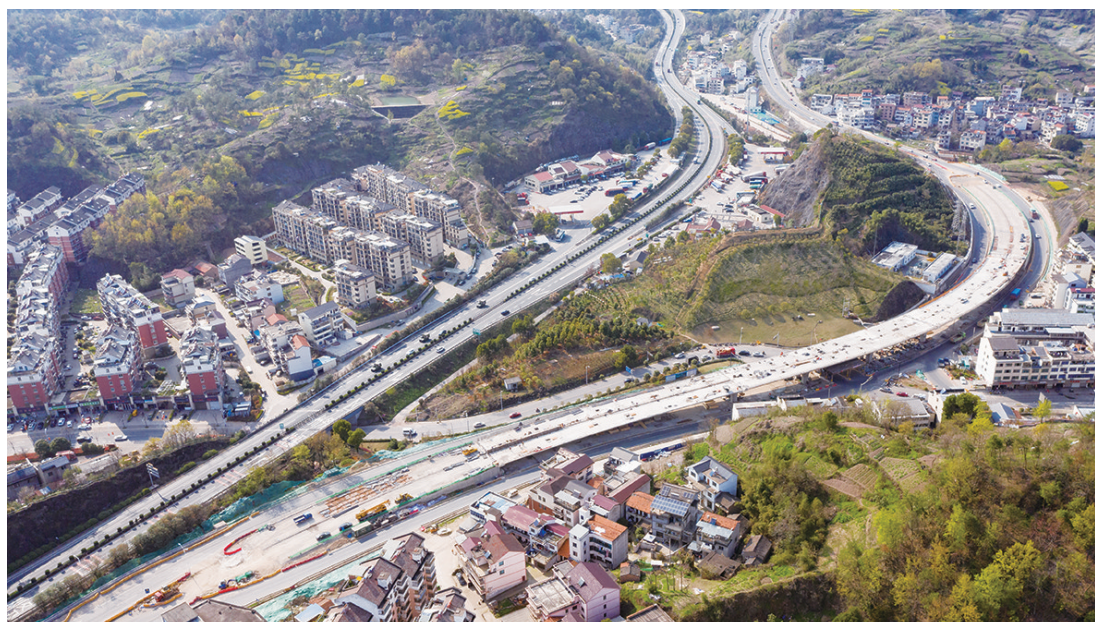
104国道南口平改立工程
