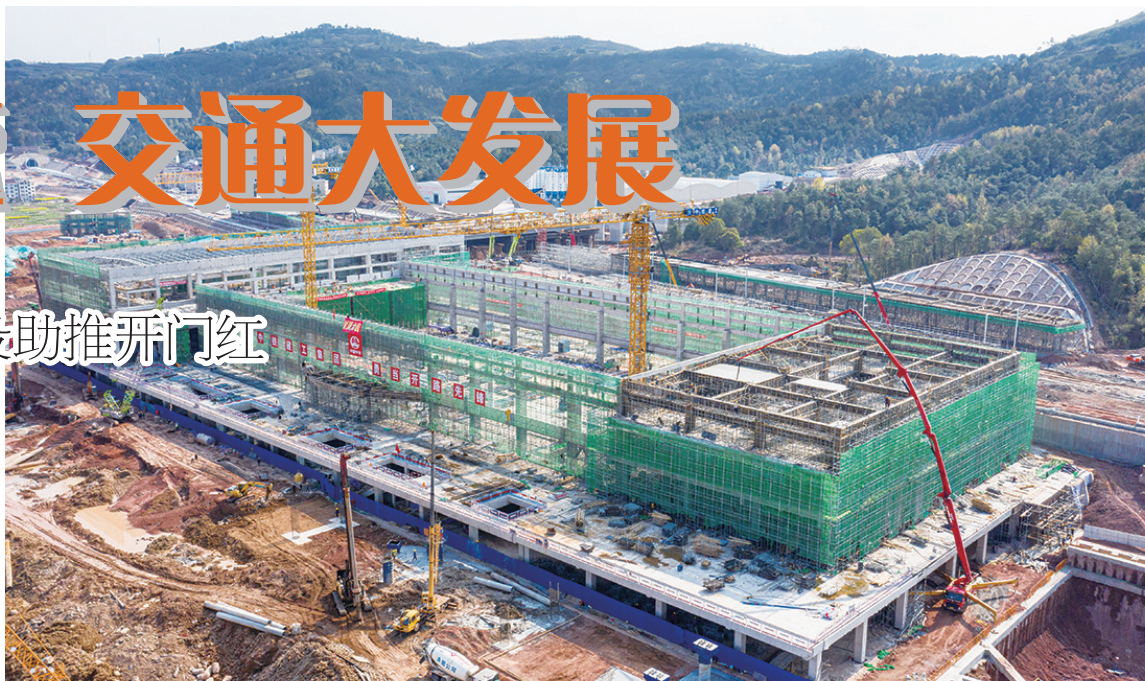
杭绍台铁路嵊州新昌站结顶
