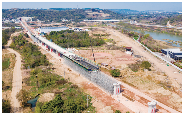
金甬铁路新昌段黄泽江特大桥
