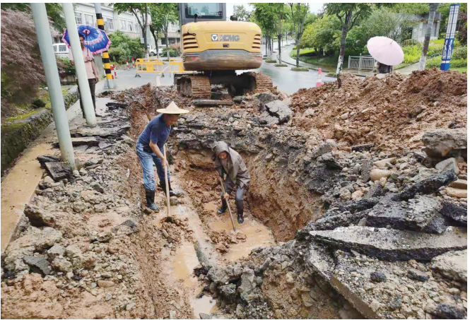
抢修破损排水管
