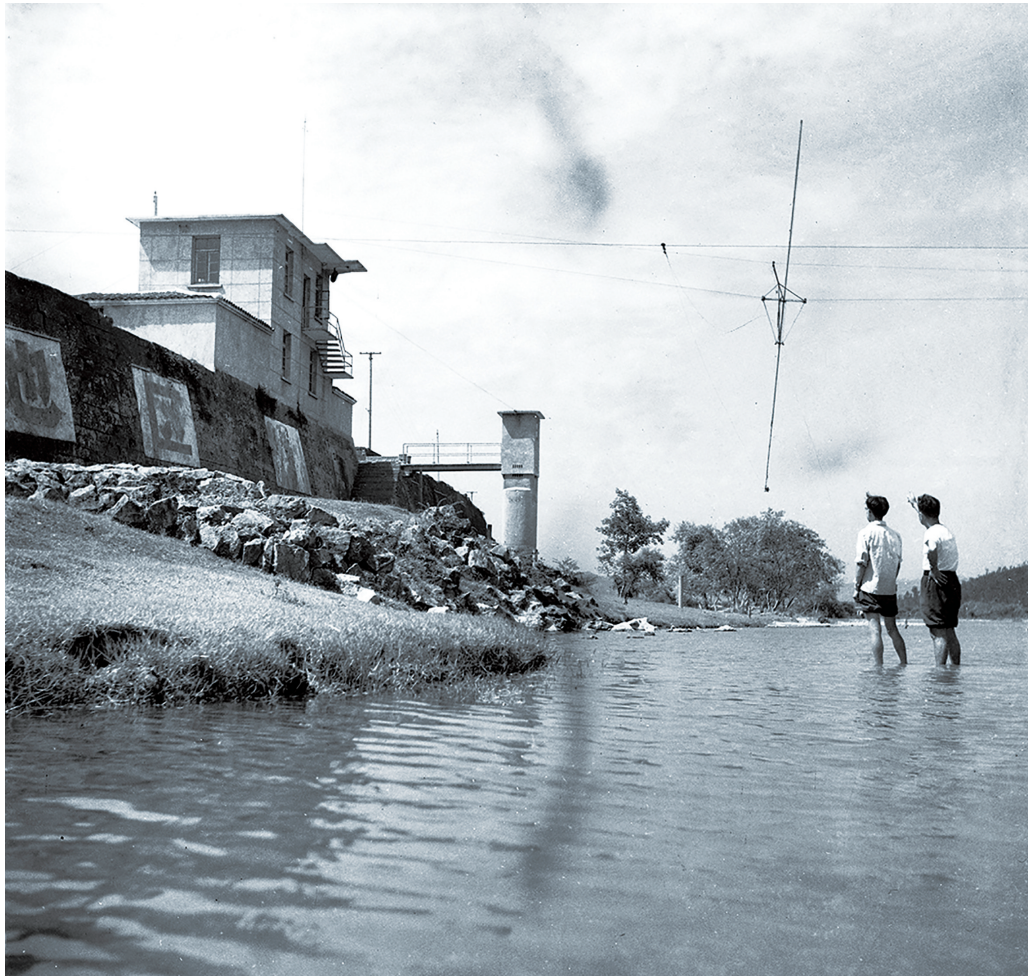
建在老城墙上的水文站综合办公楼
