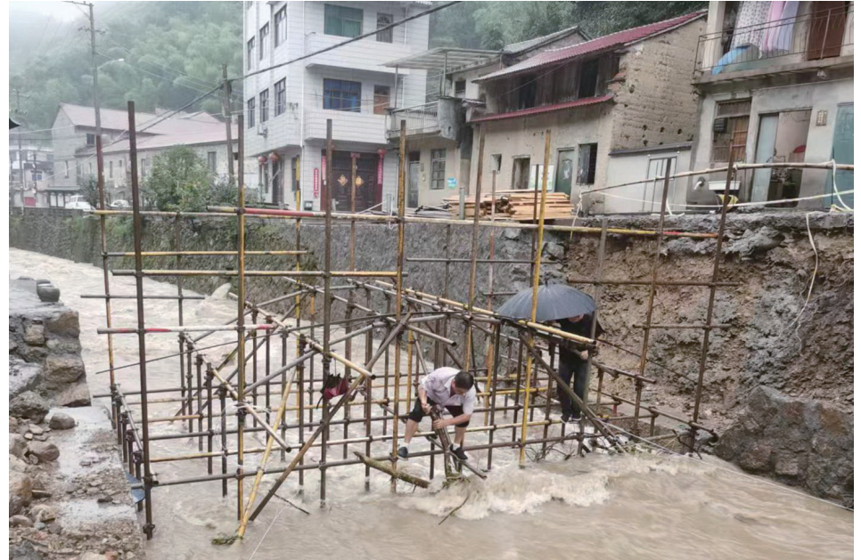
城南乡企石村紧急加固在建工程
