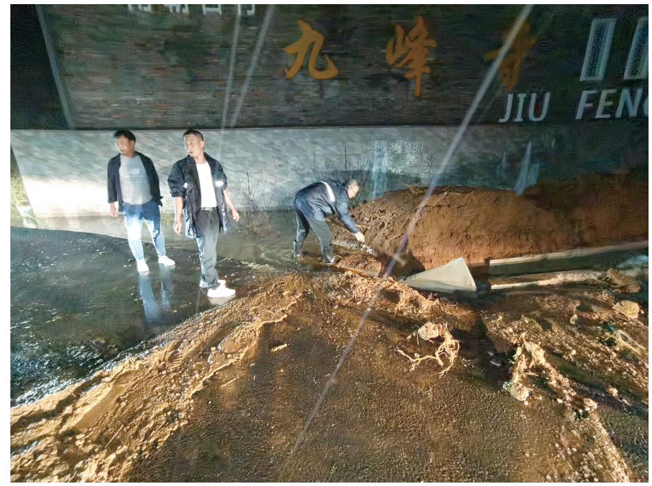
七星街道组织人员对在建项目进行积水疏通
