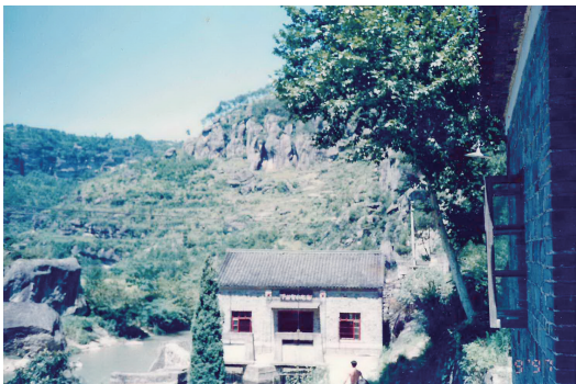
韩妃江畔多小水电站——这是下岩贝水电站
